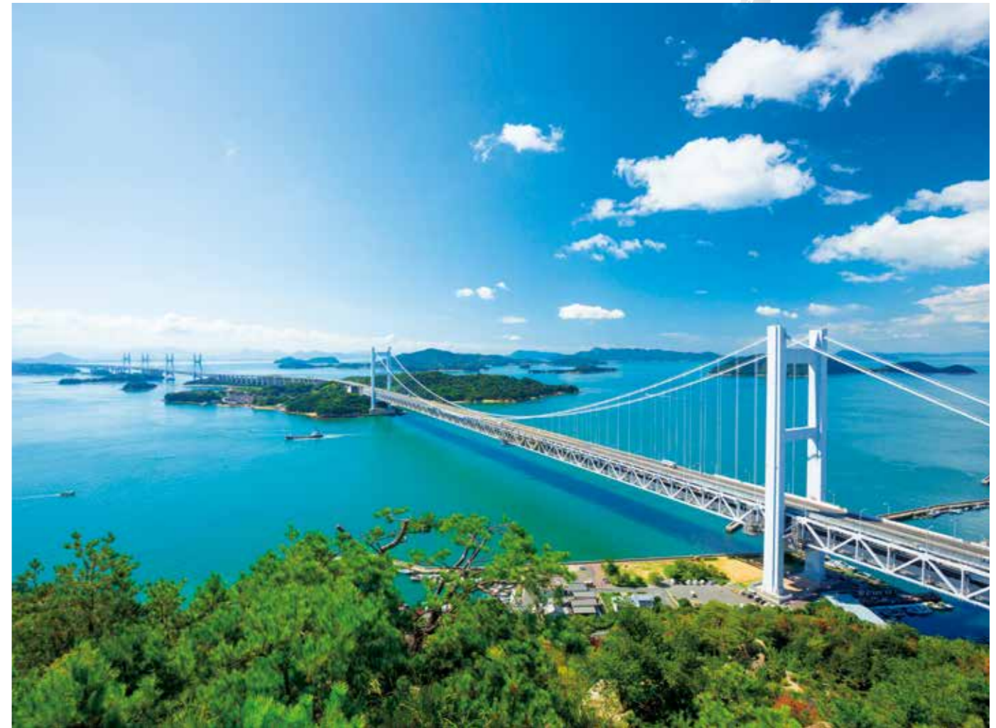
鷲羽山より瀬戸大橋
