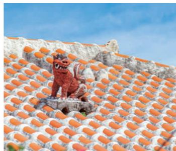
竹富島の古民家赤瓦屋根(石垣島)
